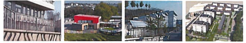
CENTRE SOCIAL LAZARE GARREAU MDE / Robin Guynesse MDA / Ville de Lille PC : Juin 2009 Livraison : 2011 ÉCOLE MALOT PAINLEVÉ - LA BRUYÈRE MDE / Atelier VongDC MDA / Ville de Lille DC : Janvier 2016 Livraison : septembre 2013 GRAND BUD MDE / Lacaton et Vassal architectes MDA / Ville de Lille PC : Novembre 2010 Livraison : fin 2013 RESIDENCE BALZAC-COLETTE MDE / Sempet Vrans et EXP MDA / LMH PC : Chantier en cours
