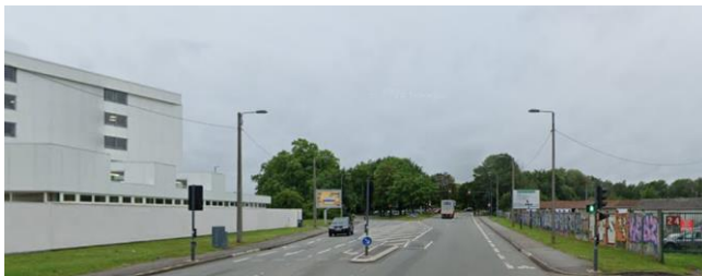
FIGURE 36 : SITUATION ACTUELLE RUE SOLFÉRINO ET AVENUE JOUHAUX | SOURCE : GOOGLE EARTH
