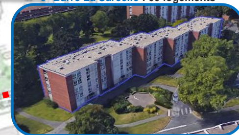
○ Barre La Sarcelle : 60 logements
