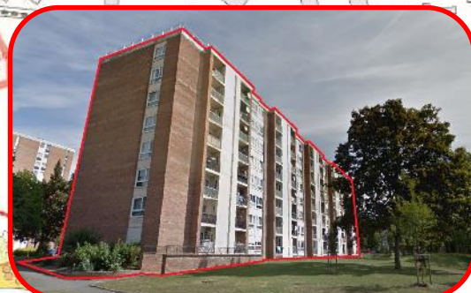
Résidence Bergeronnette : 80 logements
