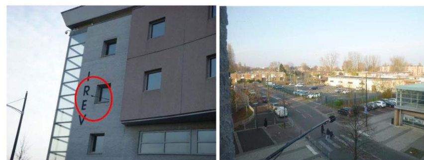
Vues de l'appareillage de mesure et du site
