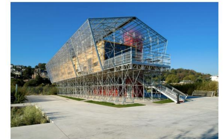
Les grandes tables de l'île Seguin à Boulogne Billancourt, espace démontable sur le principe d'un échafaudage
