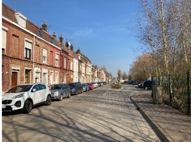
Transition avec la Rue Pasteur : formes bâties et hauteur
